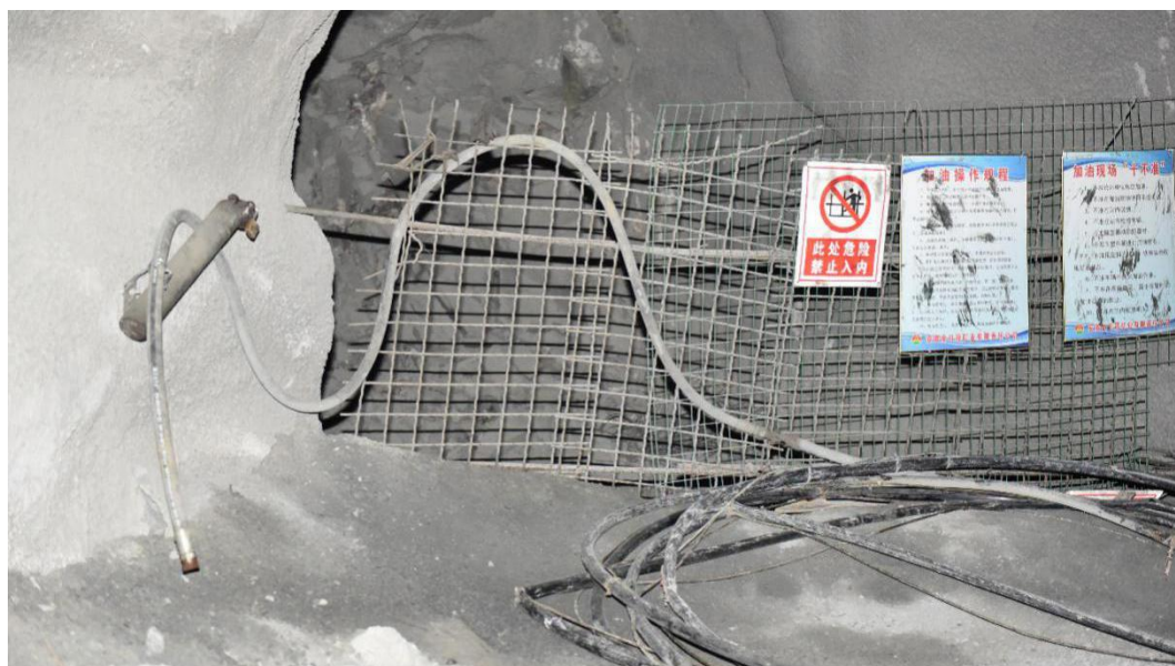
图 4 -440m 下盘沿脉与 30 号穿脉交口回风天井处卸油点
